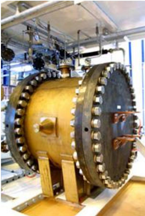
GHW on välja töötatud  $500 \text{ kW}_{\text{el}}$ , 30 bar rõhul leeliselise PME (pressure module electrolyzer) elektrolüüseri
